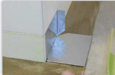
Hilfreich bei der Montage ist das unterlegen des Fußteiles im vorderen Bereich mit einer Alu-Schiene.
